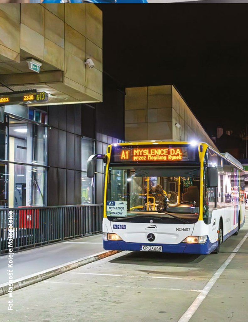
Odnowiona hala Dworca MDA w Nowym Sączu
